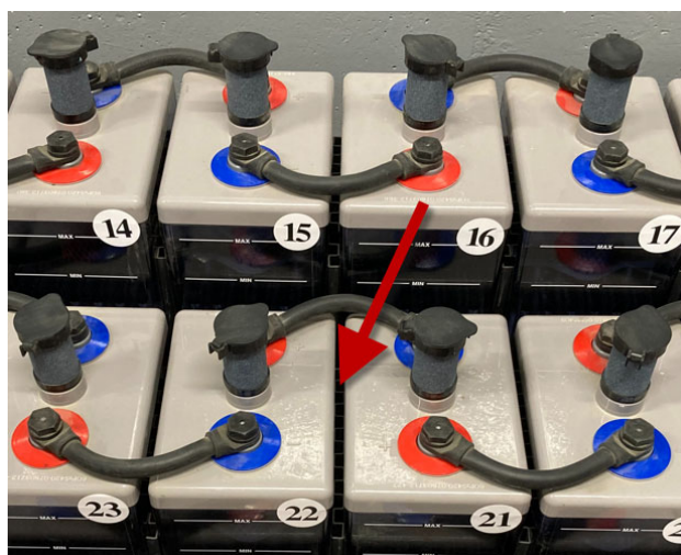
Abbildung 14: gewellte Plastikeinlagen und Nummerierung der Zellen
