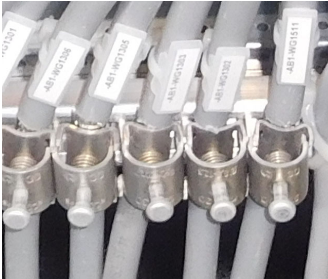
Abbildung 28: Kabelbeschriftung
