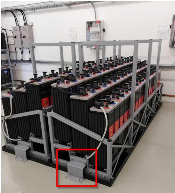
Abbildung 17: Batteriestell Befestigung am Boden
