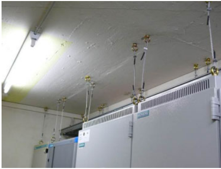
Abbildung 22: Schrankbefestigung Decke
