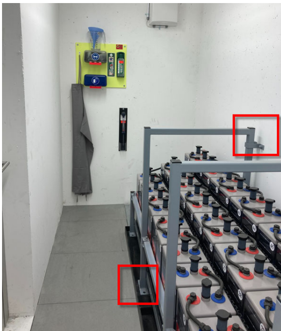
Abbildung 16: Batteriegestell Befestigung an der Wand
